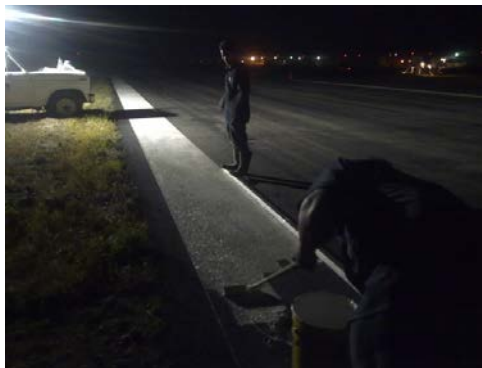
Pintura de franjas laterales
