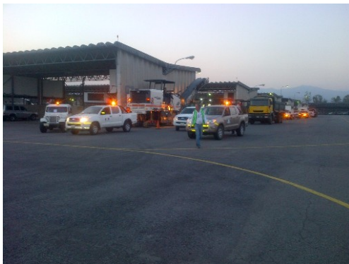
Ingreso de maquinaria a la pista
