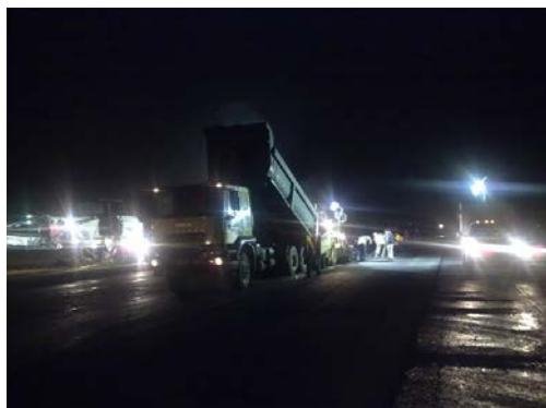
Construcción de refuerzo estructural
