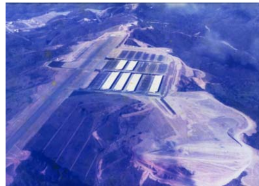
Construcción de hangares
