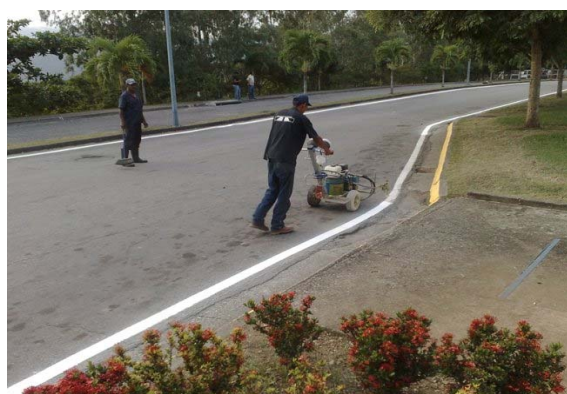
Pintura de señalización vehicular
