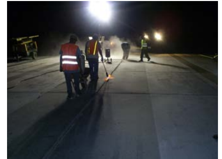
Chorro de arena y lanza térmica
